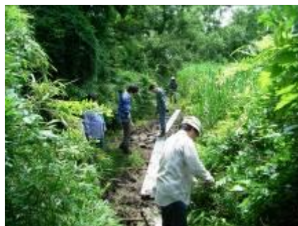
アルミ板の敷設
