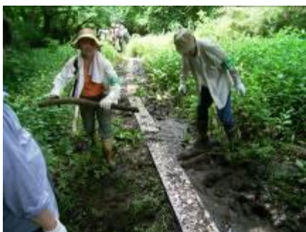
アルミ板の敷設
