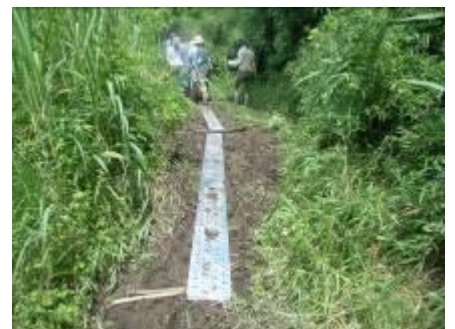
アルミ板の敷設
