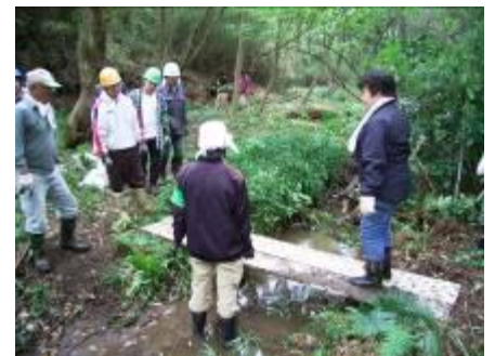
アルミ板の橋の架け替え
